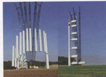
Illustrations de levage de mât et de nacelle.
